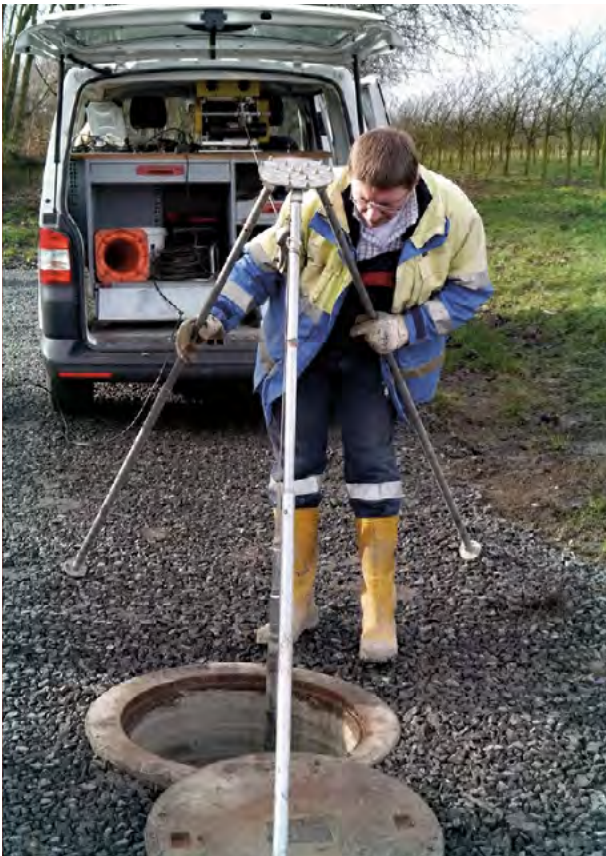
Abb. 4: Nach 1978 wurde ein geophysikalisches Bohrlocharchiv in Hessen „ermessen“. Gemessen werden können natürliche Gammastrahlung, sowie Temperatur und Salinität (Einsatz der aktuellen Bohrlochmessapparatur).
