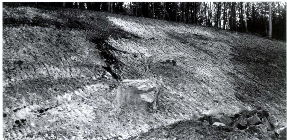
Abb. 10. SW-Rand des Tertiär-vorkommens an der Kreisstraße 69 bei Mittelkalbach mit Blöcken aus Solling-Bausandstein und eingeschleppter kohligter Ton-Schluff-Lage am Übergang zwischen Kie-sig-sandigen Basisschichten und Elmer Braunkohlenstufe.
