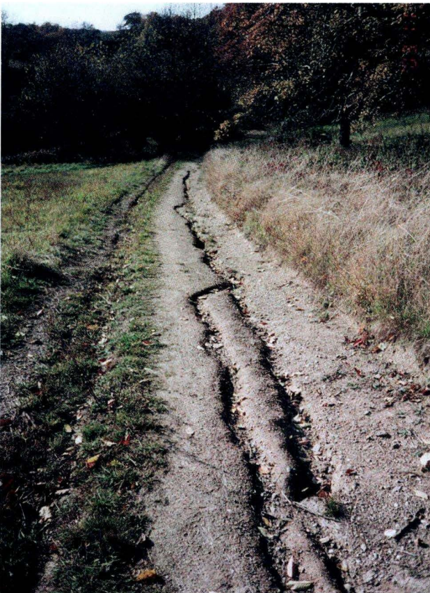
Abb. 6. Erosionsrinnen auf einem Wirtschaftsweg südlich des Hahnenkopfes bei Lorsbach.
