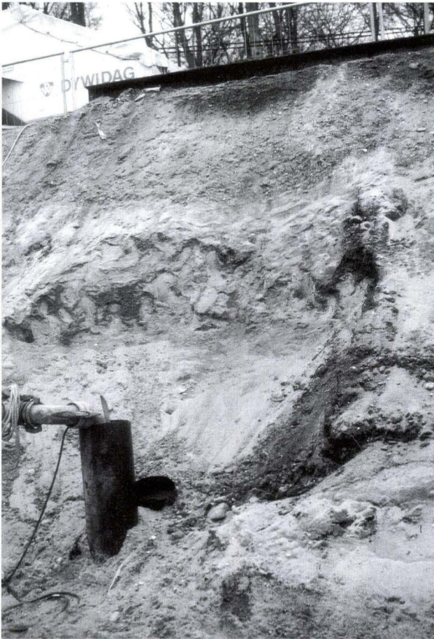
Abb. 1. Jungpleistozäner t6-Kies über altpleistozänem t1-Sand. Dem ca. einen Meter mächtigen t6-Kies fehlt hier die häufig anzutreffende basale Groblage. Der t1-Sand und eingeschaltete Schlufflagen sind kryoturbat gestört. Auf ungestörten und deshalb dichteren Schluff- oder Tonlagen bildet sich schwebendes Grundwasser, das hier in der Baugrube abgepumpt werden muß.
