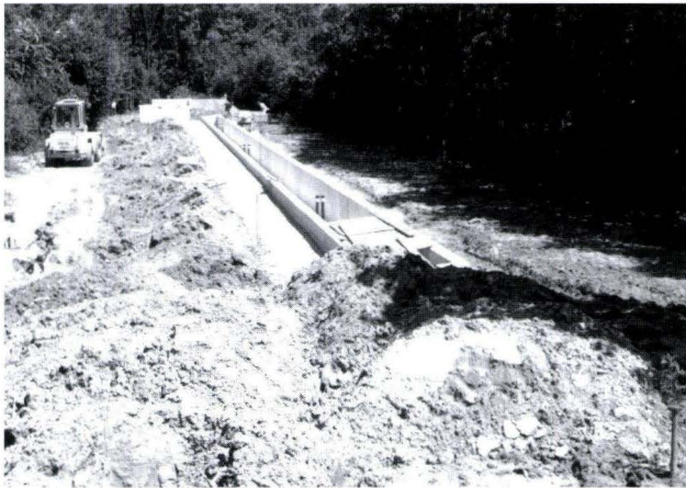
Abb. 11. Sickerschlitzengraben von 75 m Länge im Wald.
