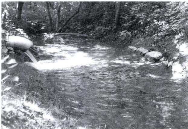
Abb. 16. Grundwasseranreicherung über einen ehemaligen Entwässerungsgraben (Waldgraben).
