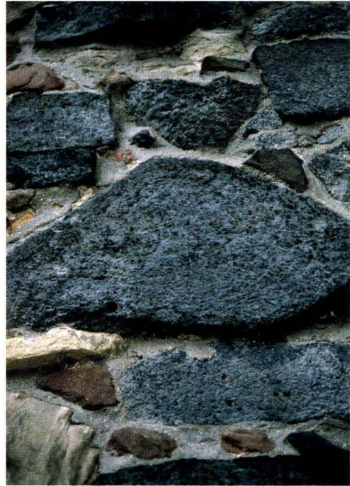
Abb. 17. Homberg/Efze, evangelische Kirche: Basaltischer Sonnenbrand mit fleckenartiger, grauer Verfärbung an der Oberfläche und nachfolgender Vergrusung.
