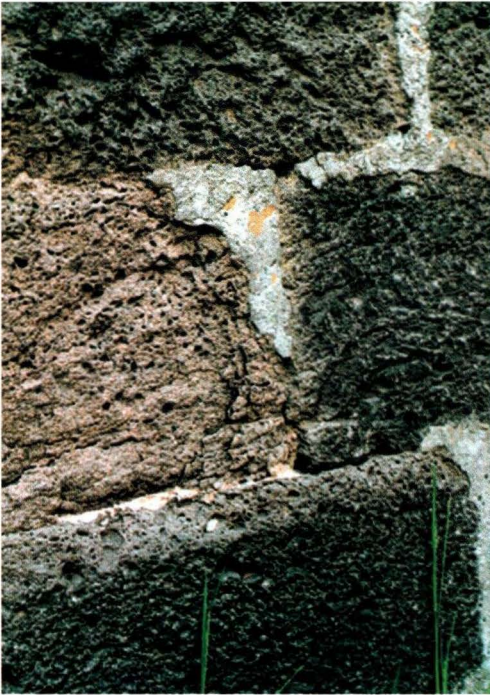
Abb. 16. Steinbach, evangelische Kirche: Basaltlava vom Londorfer Typus mit tiefgründigen Verwitterungsschäden in Form von Absanden, Aufschuppen und Abschalen.
