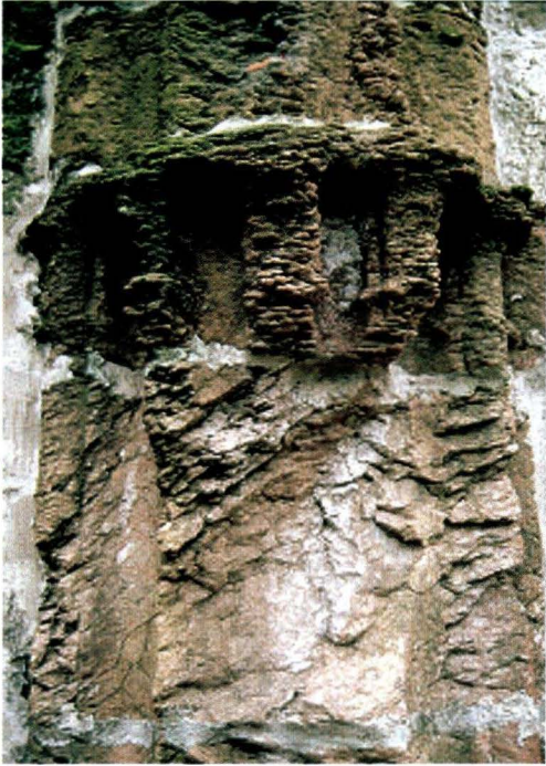
Abb. 14. Dom zu Wetzlar: Starker Verlust der historischen Architekturelemente aus Schalstein.
