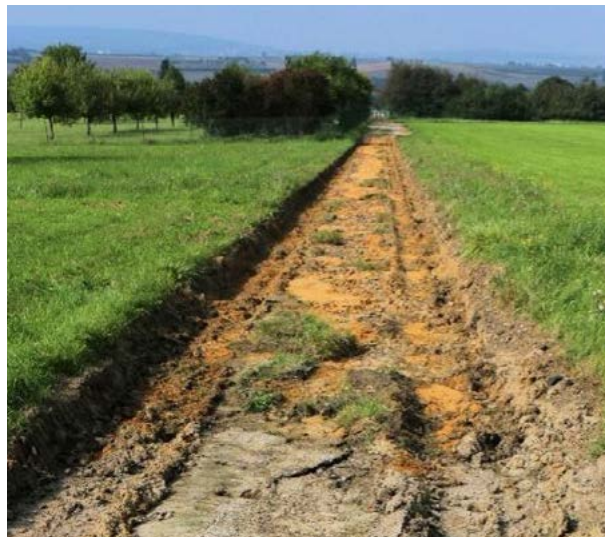
Abb. 1: Vollentsiegelung als Beispiel einer Kompensationsmaßnahme © Schnittstelle Boden
