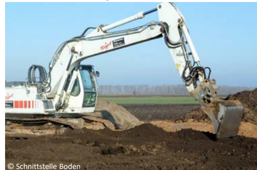
Herstellung einer durchwurzelbaren Bodenschicht
