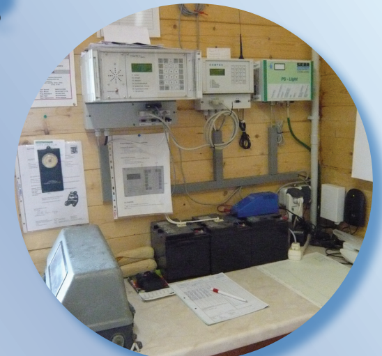
Innenansicht Pegel Büdingen (Seemenbach)
