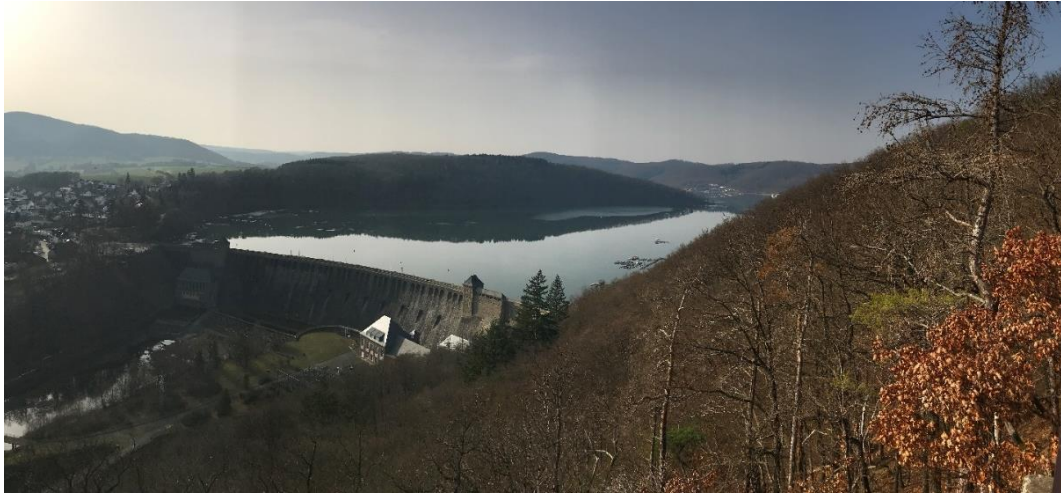
Abbildung 13: Edertalsperre bei 187 Mio m 3 Füllung (Aufnahme von der Uhrenkopfkanzel aus) – RP Kassel; 03.03.2021, ©RP Kassel (Andreas Grzywotz)
