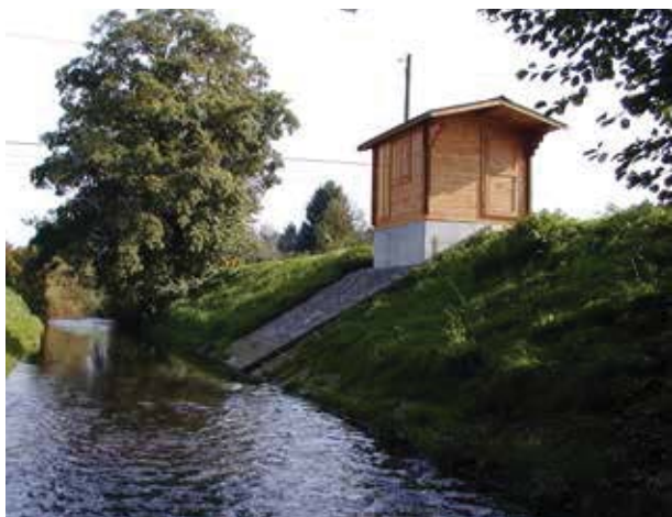
Abb. 17+18: Pegel Büdingen, Außen- und Innenansicht.
