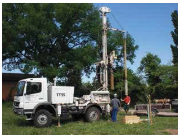
Abb. 65: Bohrung für eine Grundwassermessstelle in Trebur.
