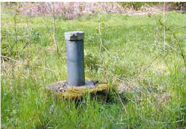
Abb. 57: Grundwassermessstelle in Frischborn, Vogelsberg.
