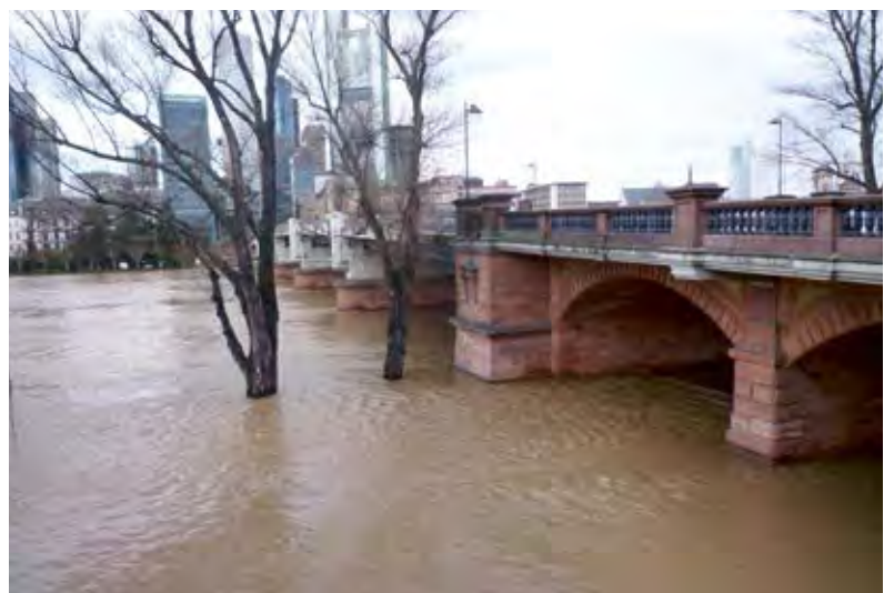
Abb. 22+23: Hochwasser Frankfurt am Main, Januar 2011.
