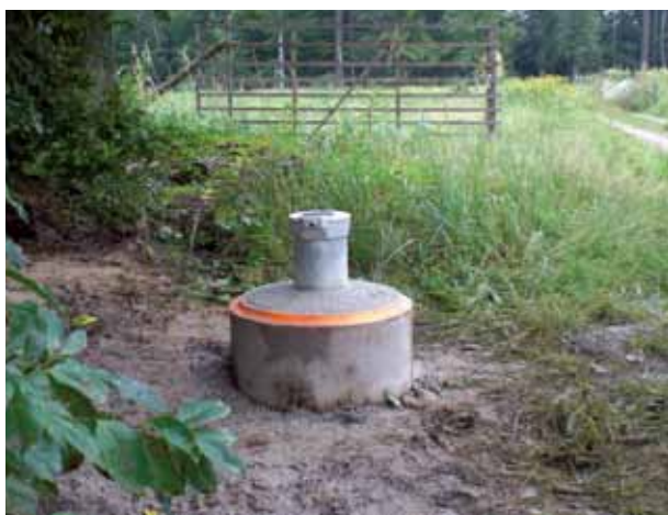
Abb. 40: Grundwassermessstelle in Viernheim, südliches Hessisches Ried.
