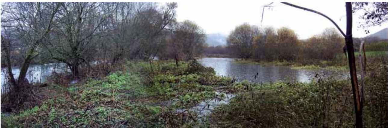
Abb. 54: Die Lahn bei Biedenkopf. Anlage eines neuen Nebengewässers vor der Kläranlage.
