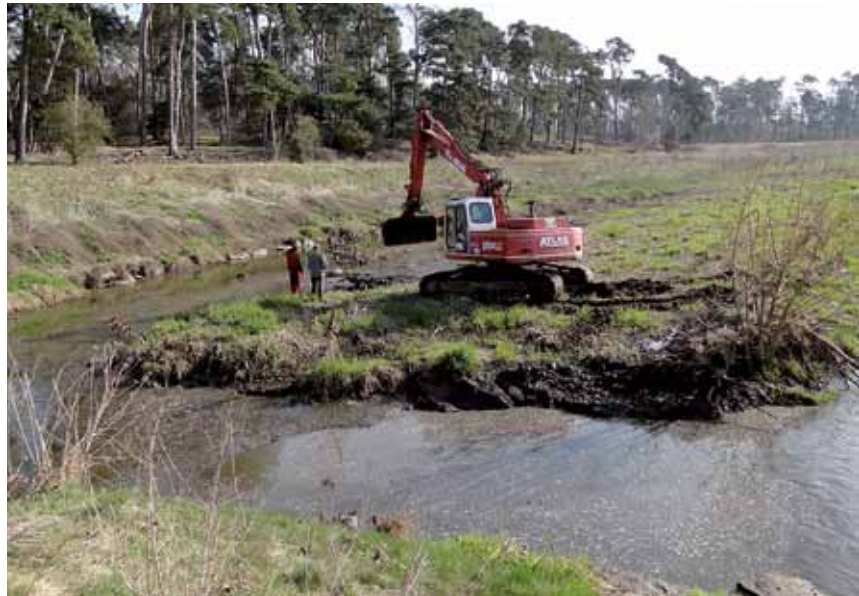
Abb. 57: Ausbaggerung von Sand und Schlamm in angelegter Schleife an der Weschnitz bei Einhausen.
