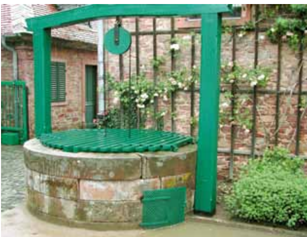
Abb. 44: Schachtbrunnen in Langen.
