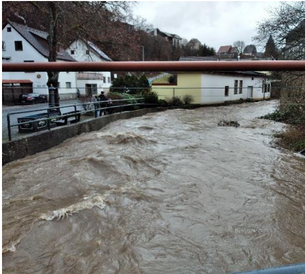
Abbildung 44: Hochwasser am Pegel Rod an der Weil 29. Januar 2021, Foto: H. Köster (RP Gießen)
