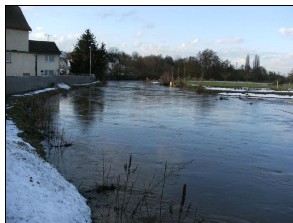
Wetter in Bruchenbrücken (einseitige Hochwasserschutzmauer), Quelle: Wasserverband Nidda
