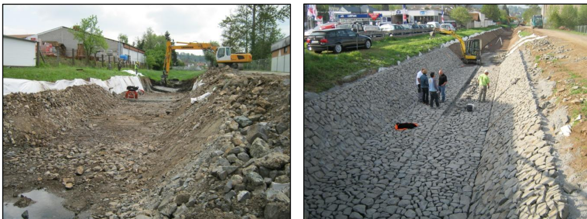
Abbildung 3.13: Ausbau der Flutgrabens in der Stadt Nidda, Quelle: BGS Wasser
