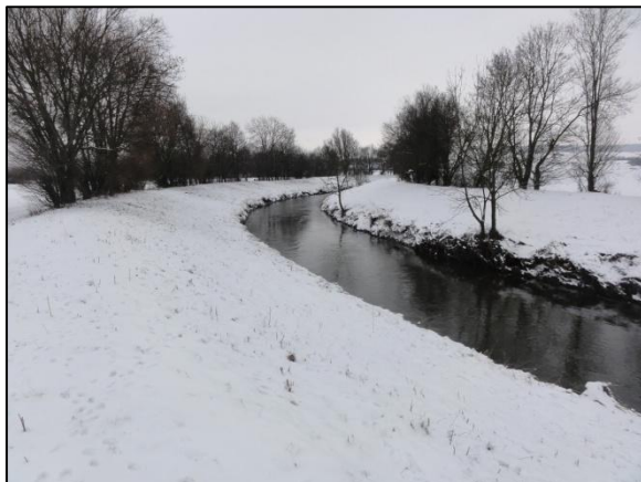
Nidda oberhalb von Karben (beidseitiger Hochwasserschutzdeich), Quelle: BGS Wasser
