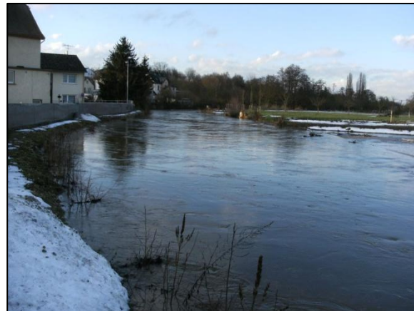
Wetter in Bruchenbrücken (einseitige Hochwasserschutzmauer), Quelle: Wasserverband Nidda
