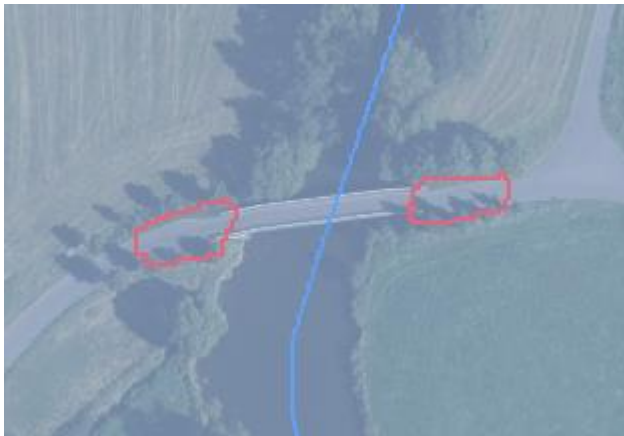
Abbildung 2-22: Umströmte Brücke bei Queck
