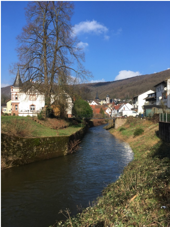
Foto 5: Verlauf der Steinach unmittelbar vor ihrer Mündung in Neckarsteinach, 28.02.2020
