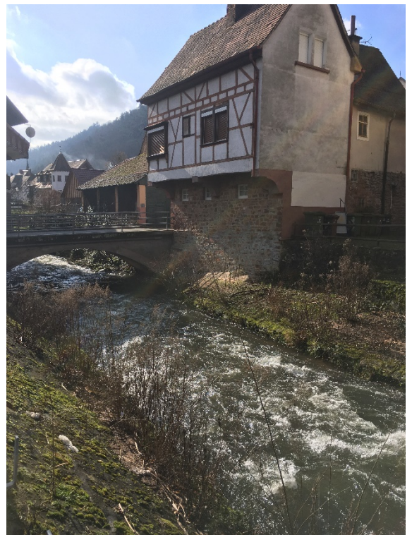
Foto 4: Verlauf der Steinach, Steinachbrücke Neckarstraße in Neckarsteinach, 28.02.2020
