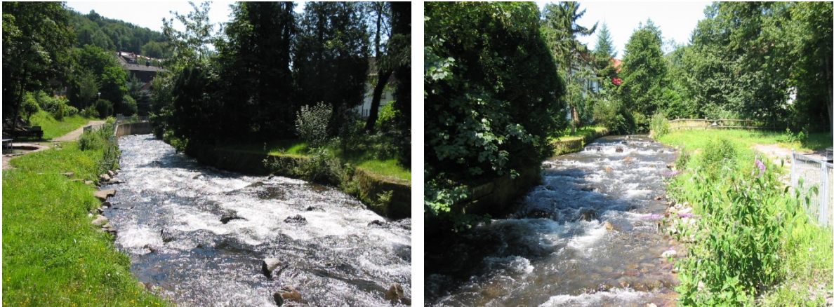
Abbildung 6: Umgesetzte WRRL-Maßnahme (Fischaufstiegsanlage) in Neckarsteinach
