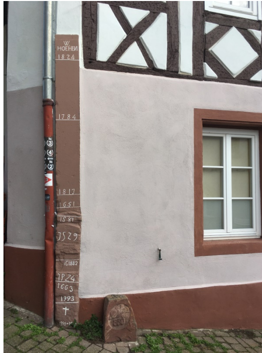
Abbildung 5: Historische Hochwassermarken im alten Stadtkern in Neckarsteinach im Mündungsbereich der Steinach in den Neckar: Hauptursache sind Neckarhochwasser (eigene Aufnahme, 2020)
