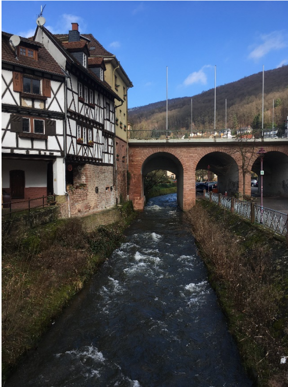
Foto 1: Steinachbrücke der B 37 in Neckarsteinach, 28.02.2020
