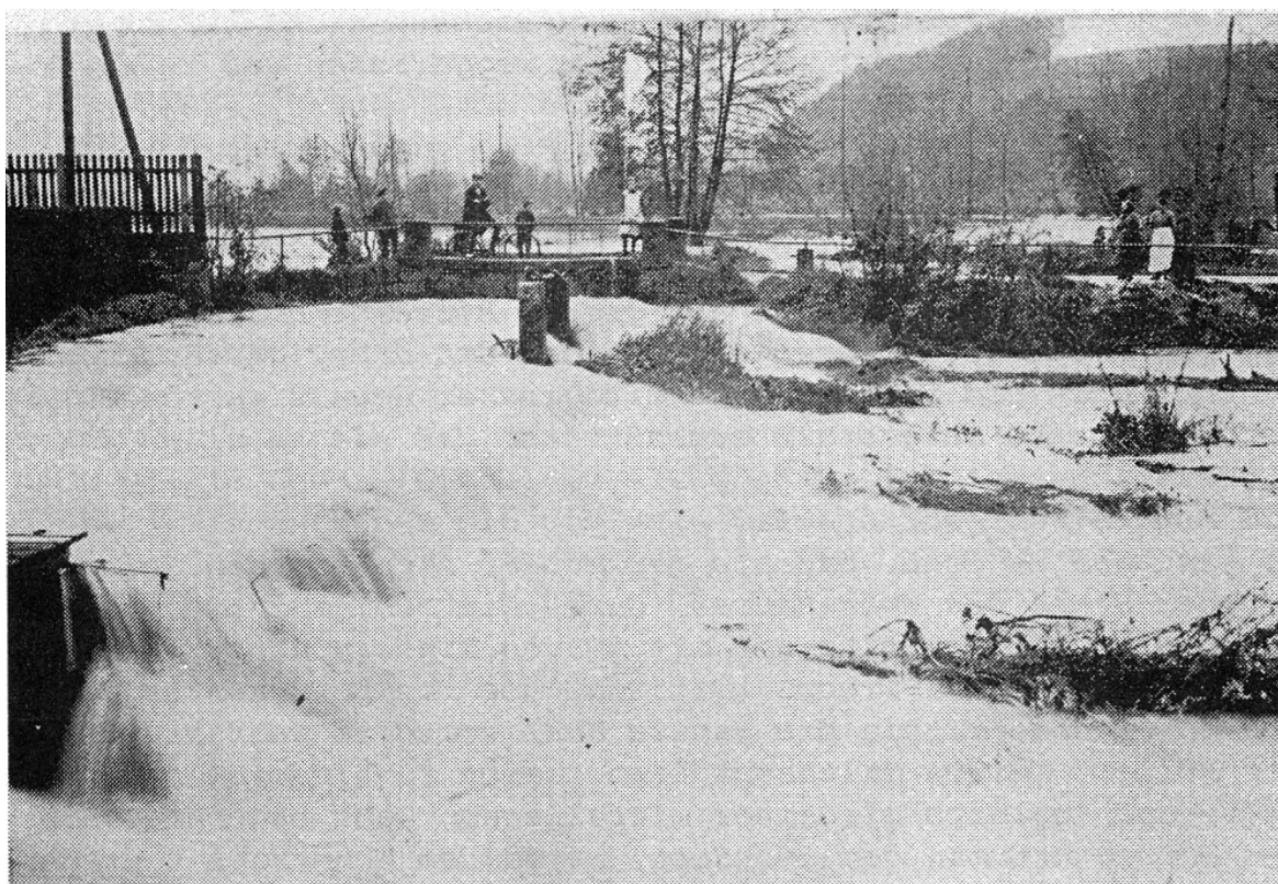
Abbildung 3.3: Hochwasser 1924 in Etzen-Gesäß, aus [5]
