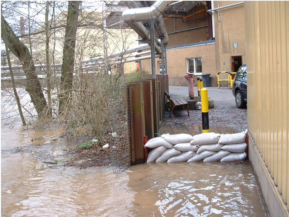
Abbildung 3.8: Hochwasserschutzwand der Pirelli Deutschland GmbH. Foto: Pirelli Deutschland GmbH
