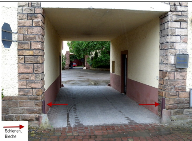
Einfahrt Firma Maul GmbH
