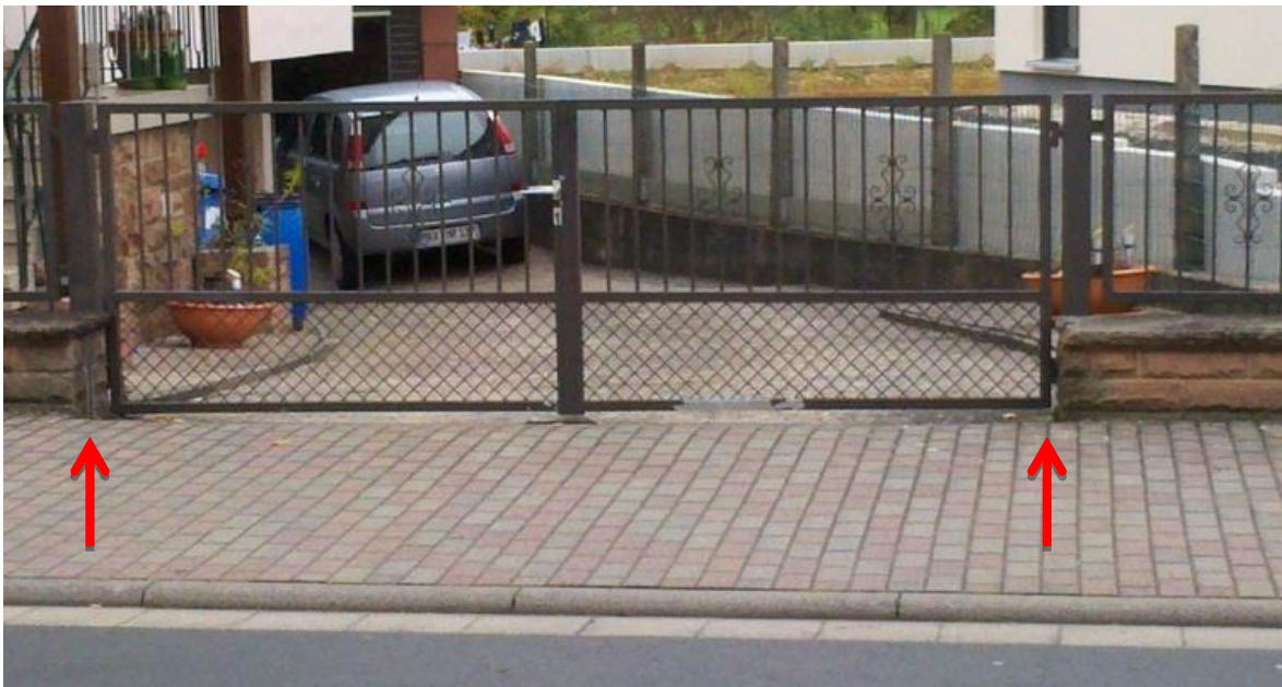
Abbildung 3.2: Beispiel einer Objektschutzmaßnahme: Schienen / Bleche im Bereich der Hofeinfahrt.
