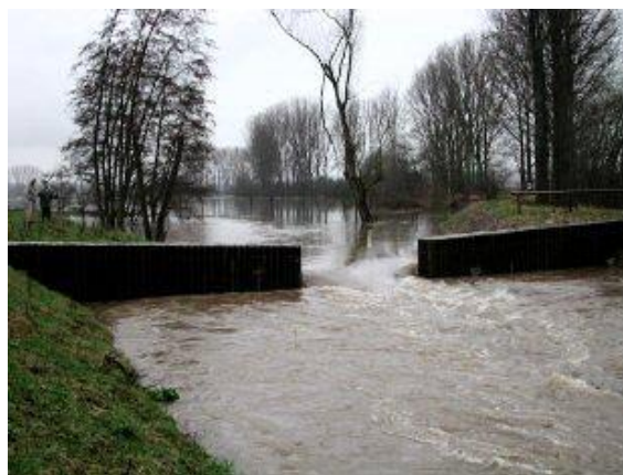
Abbildung 3.12: Drosselbauwerk des Retentionsraums Groß-Zimmern bei Hochwasser, Quelle: Wasserverband Gersprenzgebiet
