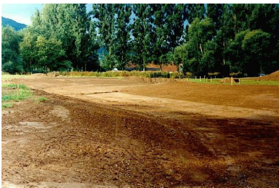
Flutmulde in der Bauphase
