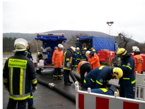
Aufbau der Saugleitungen am Pumpenschacht "Vaaker Weg" beim Hochwasser 2012
