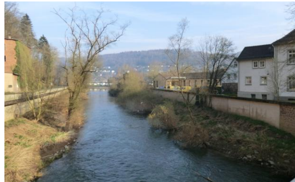
Hochwasserschutzmauer in Bad Karlshafen
