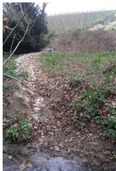
Abbildung 9: Sandfang im Renaturierungsbereich des Sülzbachs.
