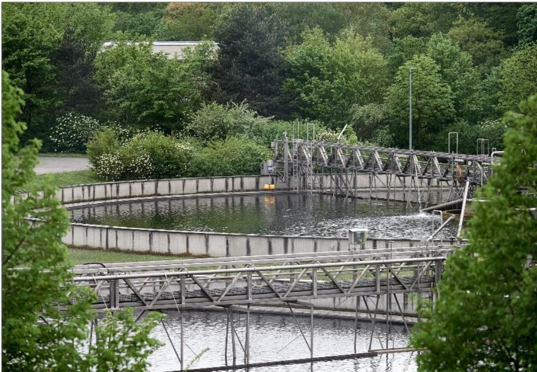
Abb. 23: Nachklärbecken des Zentralkläwerks Darmstadt (Foto: ENTEGA Abwasserreinigung GmbH & Co.KG)
