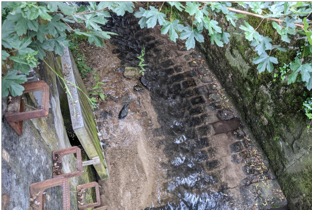
Abb. 5: Auslass einer Mischwasserentlastungsanlage (Foto: HLNUG, Wiesbaden)
