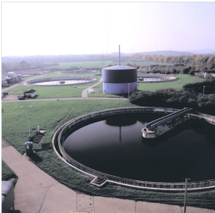
Abb. 4: Nachklärbecken des Klärwerks Gießen (Foto: MWB – Mittelhessische Wasserbetriebe).
