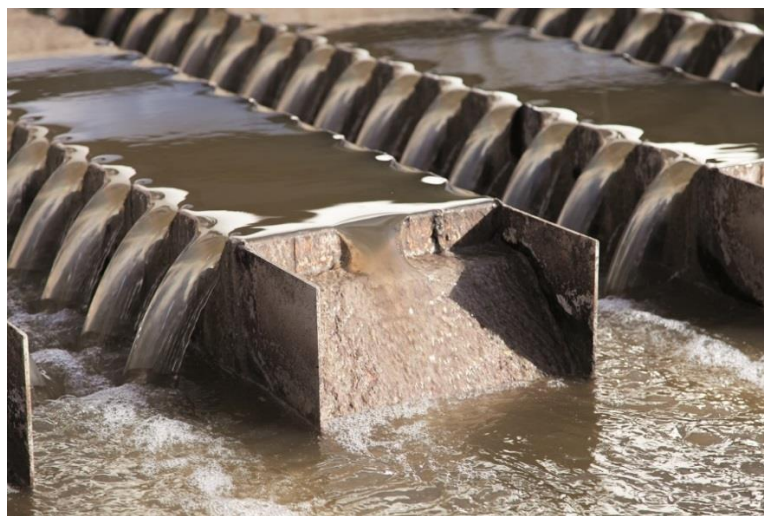
Abb. 19: Detailansicht Ablauf Vorklärbecken des Klärwerks Gießen (Foto: MWB – Mittelhessische Wasserbetriebe).
