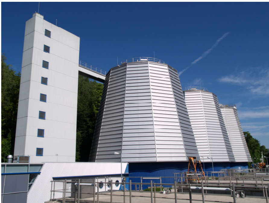
Abb. 1: Faultürme des Hauptklärwerks Wiesbaden (Foto: ELW–Wiesbaden).
