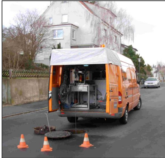
Abb. 1: Kanalinspektion (Foto: Stadtwerke Hünfeld).
