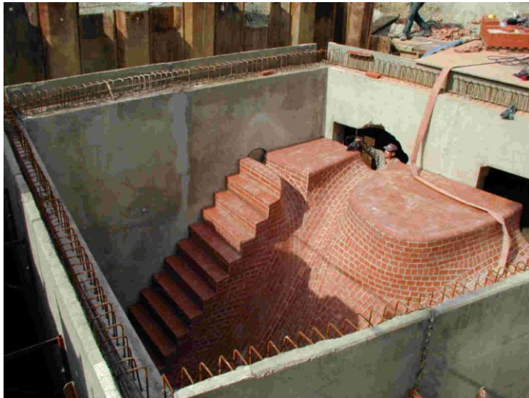
Abb. 7: Bau eines Stauraumkanals (Foto: AV Wetzlar).
