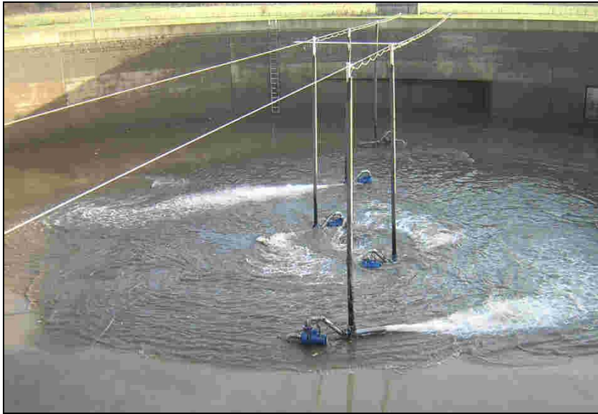
Abb. 5: Entleerung / Reinigung eines Rückhaltebeckens (Foto: Stadtwerke Hünfeld).
