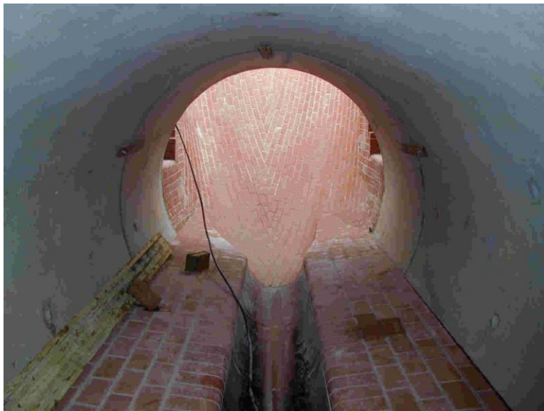
Abb. 8: Bau eines Stauraumkanals (Foto: AV Wetzlar).
