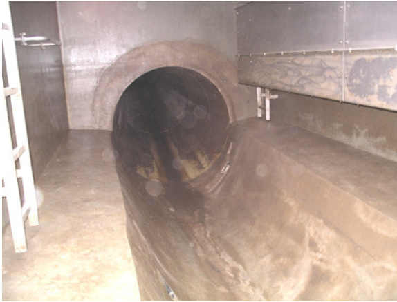
Abb. 1: Überlauf eines Stauraumkanals
