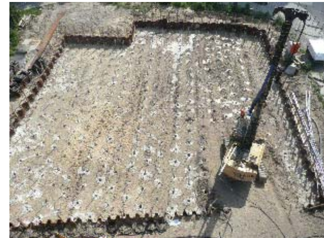
Bauer Spezialtiefbau GmbH
