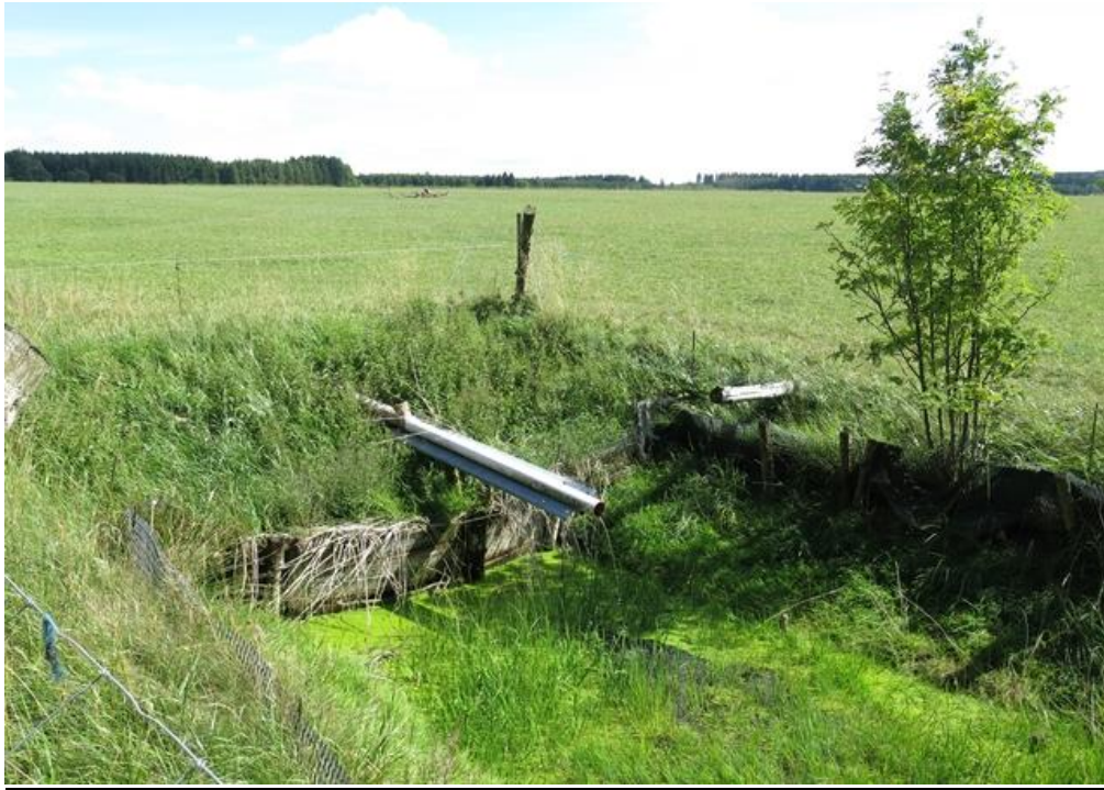
Abbildung 6: Gefasste Quelle im Untersuchungsgebiet. Es wird empfohlen, den Quellbereich und den Quellabfluss wieder in einen möglichst naturnahen Zustand zu versetzen.
