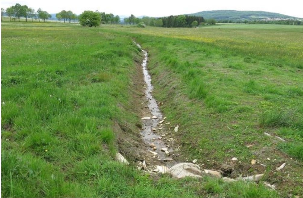
Abbildung 7: 2015 ausgebagerte Grabenbereiche auf der Tanner Hute. Der Grabenaushub wurde auf dem angrenzenden Grünland aufgebracht. Eine Vertiefung der im Gebiet vorhandenen Gräben muss unbedingt unterbleiben, um negative Auswirkungen auf den Wasserhaushalt der angrenzenden Flächen zu verhindern. Sollte eine Austiefung der Gräben erfolgt sein, ist diese rückgängig zu machen.
