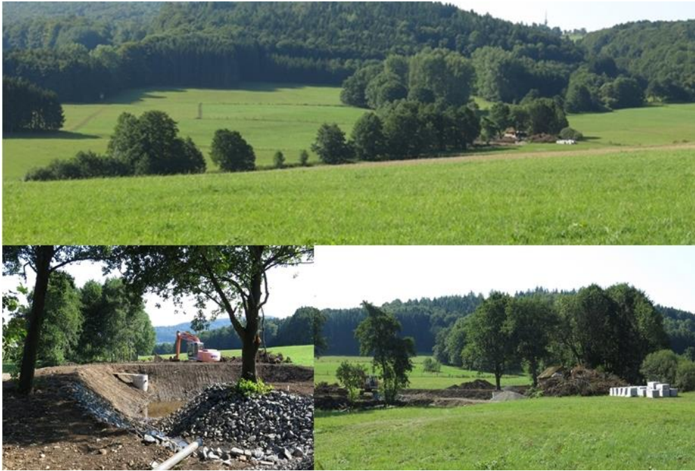
Abbildung 13: Im oberen Bildteil ist die dicht mit Ufergehölzen gesäumte Anze zu erkennen, an die zum Teil noch feuchtere Grünlandflächen angrenzen. Im abgebildeten Abschnitt wurden 2015 Baumaßnahmen durchgeführt (siehe unterer Bildteil). Es sollte sichergestellt sein, dass die baulichen Tätigkeiten zu keiner qualitativen Verschlechterung – insbesondere Entwässerung - angrenzender Biotope führen.
