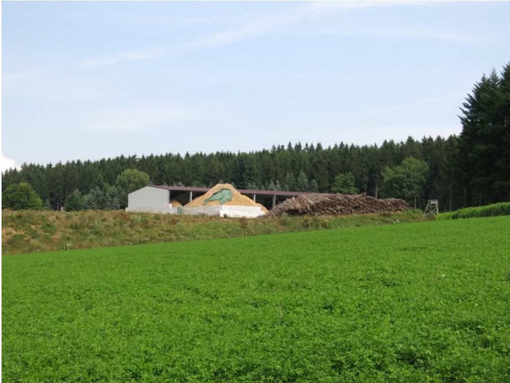
Abbildung 12: Nördlich des Untersuchungsgebiets gelegene Gebäude des Sägewerkes.
