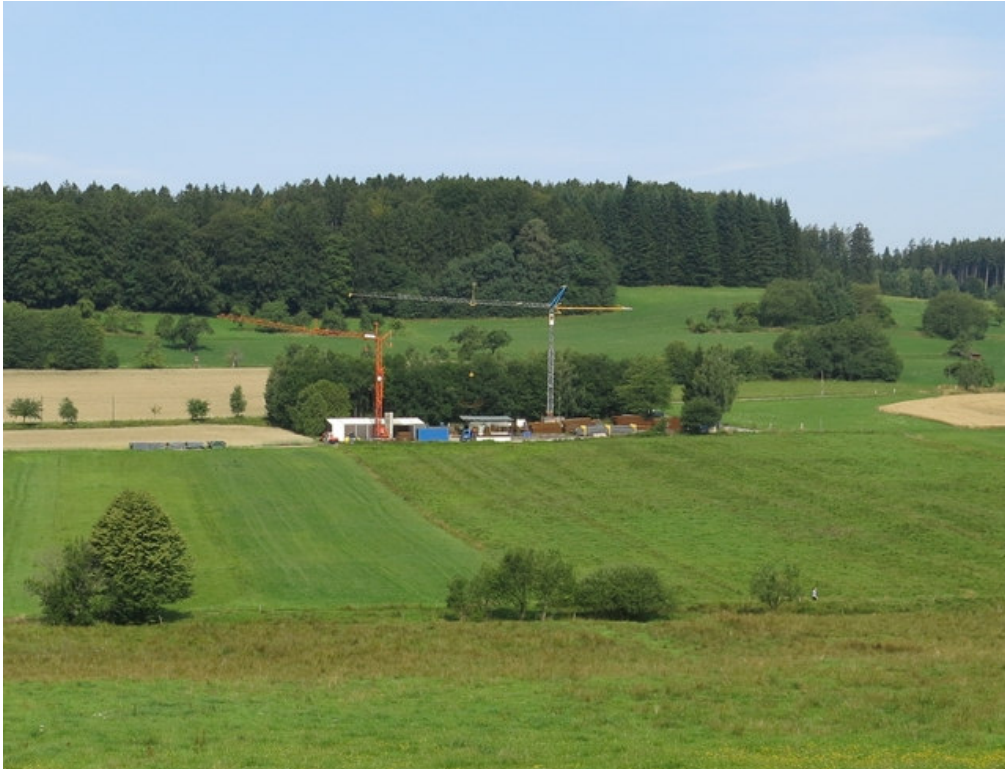
Abbildung 8: Blick über die im Süden des Gebietes gelegene Talbereiche. Die Baustelle befindet sich an der nordwestlichen Grenze des LSG. Das in den vorderen Bildabschnitten und der Bildmitte zu sehende Grünland liegt innerhalb der LSG-Grenze.
