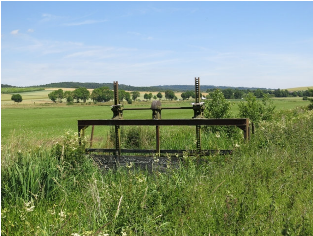
Abbildung 3: Graben mit Schleuse in der Ederau bei Rennertehausen
