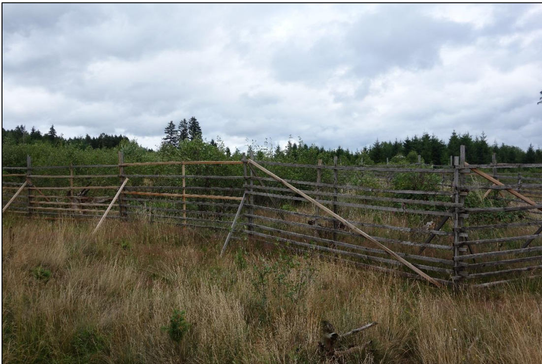
Abbildung 6: Die zum Wald sowie Grünland hin vorhandenen Absperrungen zeigen, dass derzeit wohl Aufforstungsmaßnahmen auf der Fläche des Windwurfs stattfinden. Hier gilt es gemeinsam mit den Flächenbewirtschaftern bzw. -eigentümern (Forst und Landwirte) eine Regelung zu finden, die den Raubwürger-Lebensraum nicht beeinträchtigt und gleichzeitig mit den Zielen der Eigentümer vereinbar ist.
