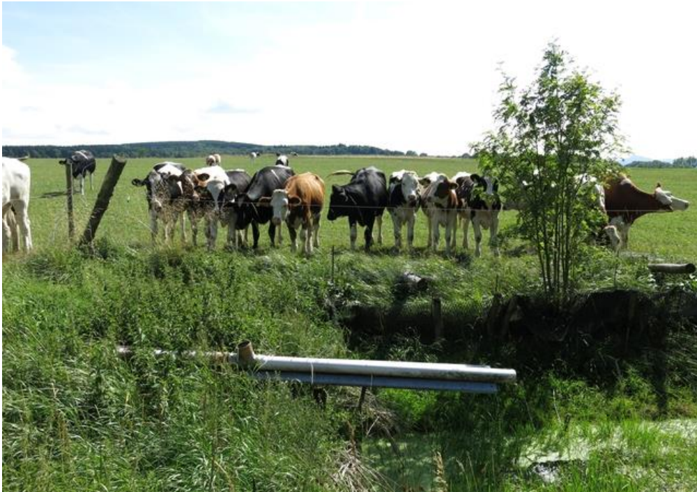
Abbildung 12: Gefasste Quelle nördlich der Tanner Hute. Es sollte geprüft werden, ob Quellbereich und Quellabfluss wieder in einen möglichst naturnahen Zustand zurückversetzt werden können. Für die strukturarme Weidefläche im Bildhintergrund wird der Erhalt von inselartigen Brachflächen (nötigenfalls auskoppeln) und Saumstrukturen empfohlen.
