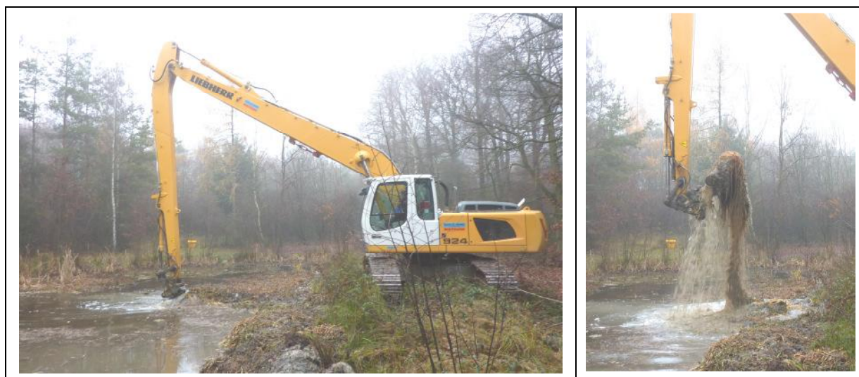
Abb. 8: Baggereinsatz mit Augenmaß am Zoologentümpel (LB1)
