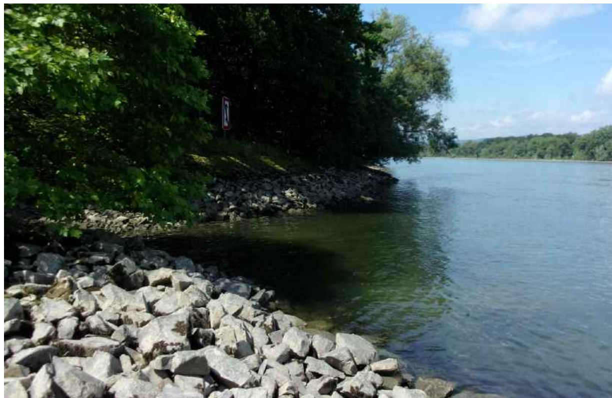
Abb. 9: Überwiegend durch Steinschüttungen verbautes Ufer innerhalb der PF Mariannenaue (Foto: L. Friedel).
