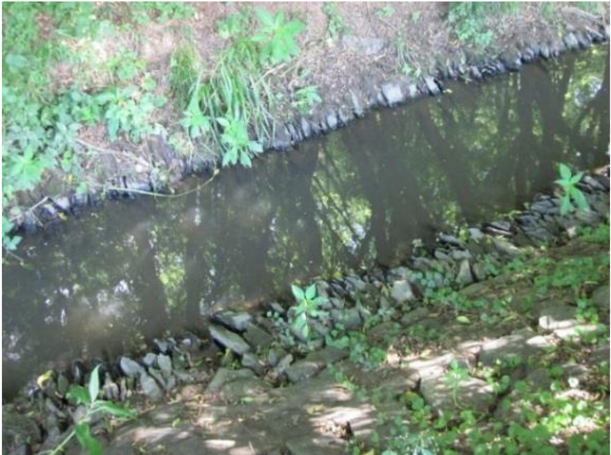
Abbildung 8 Wickerbach mit intaktem „Nassauer Gesteck“ (PS w3)
