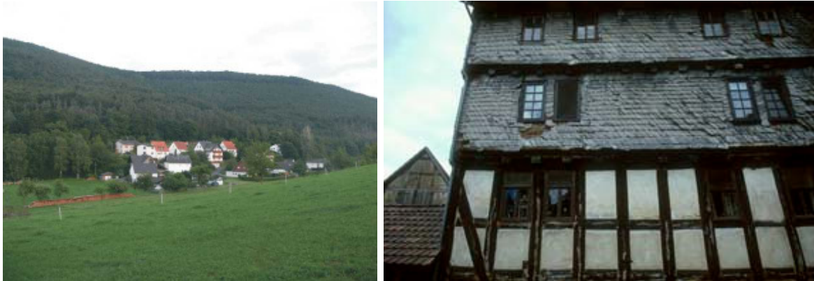
Abb. 4: Schieferfassade mit Quartiermöglichkeiten für die größte Wochenstubenkolonie der Mopsfledermaus in Elmshausen im oberen Lahntal.
