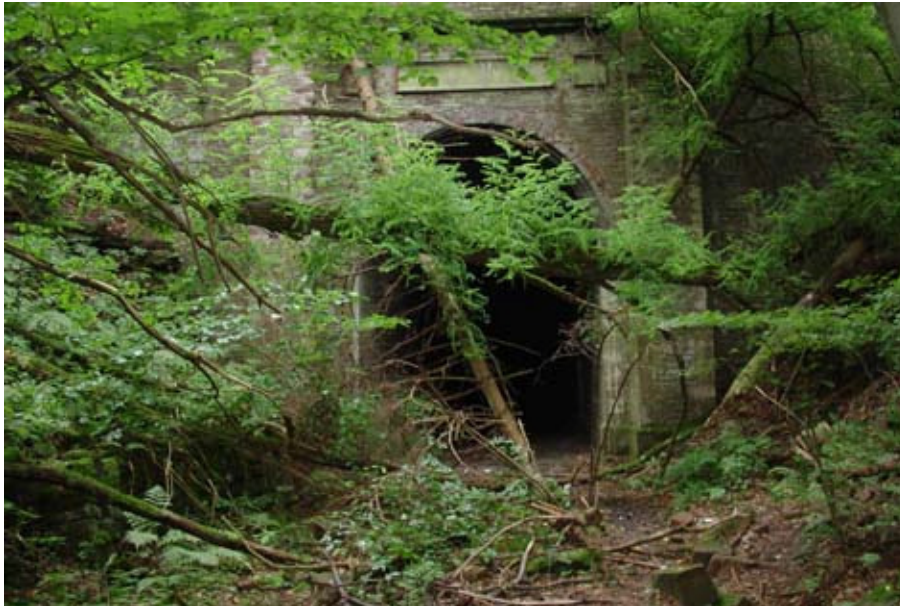
Abb. 14: Winterquartier Tunnel Trendelburg der Mopsfledermaus.
