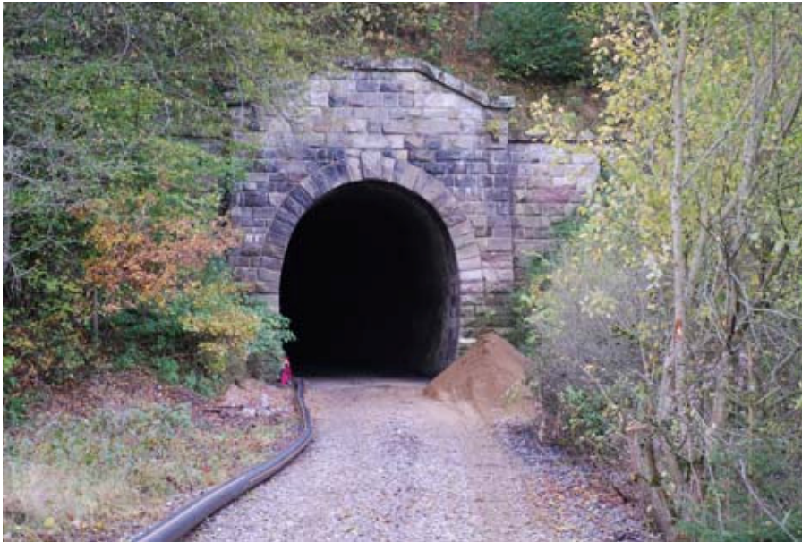
Abb. 15: Winterquartier Tunnel Dodenau der Mopsfledermaus
