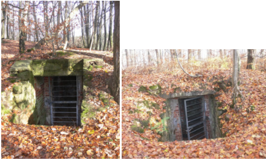
Abb. 10: Unterer und Oberer „Behring“-Stollen. Am Oberen Stollen ist die Vergitterung des Eingangs aufgebrochen.
