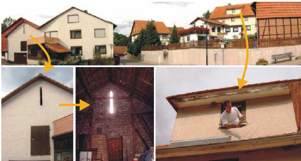
Abb. 6: Nachtquartier in einem ausgebauten Dachboden (links, Feldnäsche 12) und Tagesquartier zwischen Wandverkleidung und Dachziegeln (rechts, Feldnäsche 9) einer männlichen Kleinen Hufeisennase (Rhin1) in Rambach, ermittelt über ein an der Schäferburghöhle besendertes Tier.
