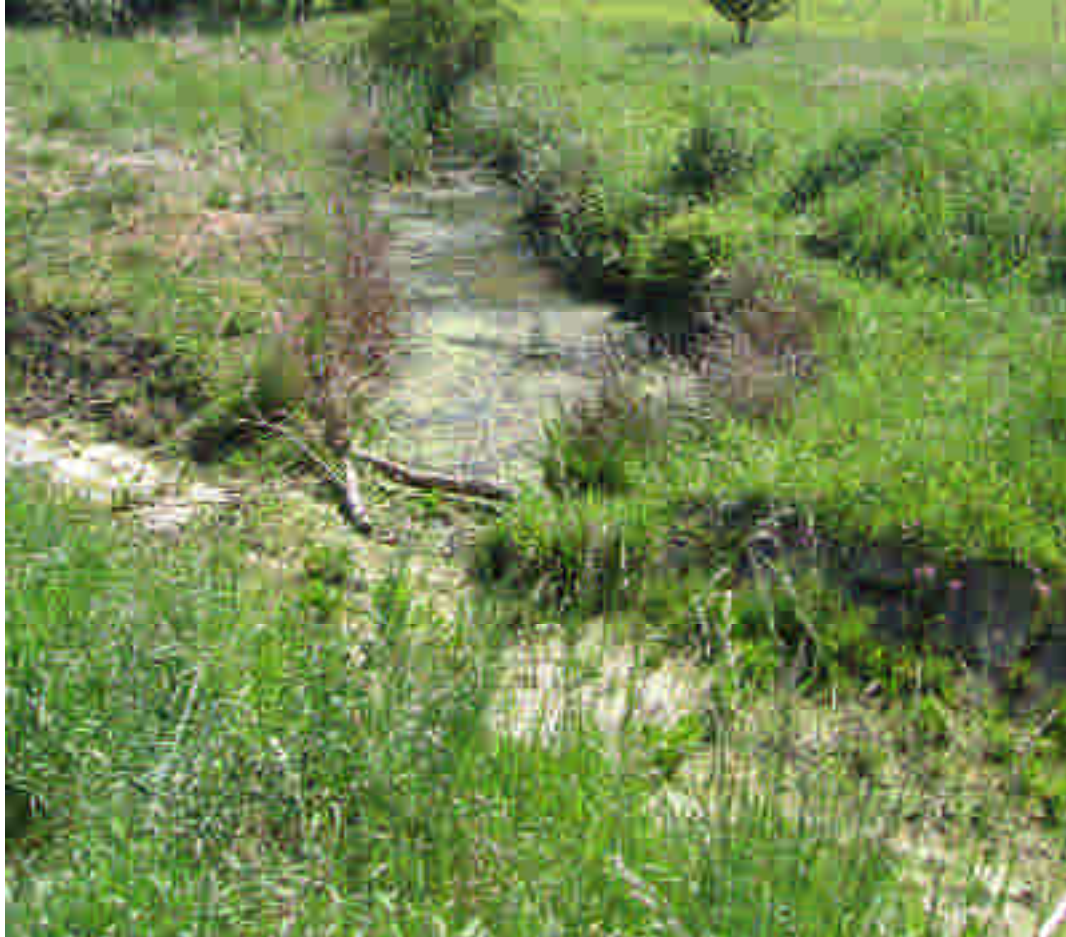
Abb. 5.3.1.1: Grabenschleife in Bensheim, 21.6.2008, Photo R. HENNINGS
