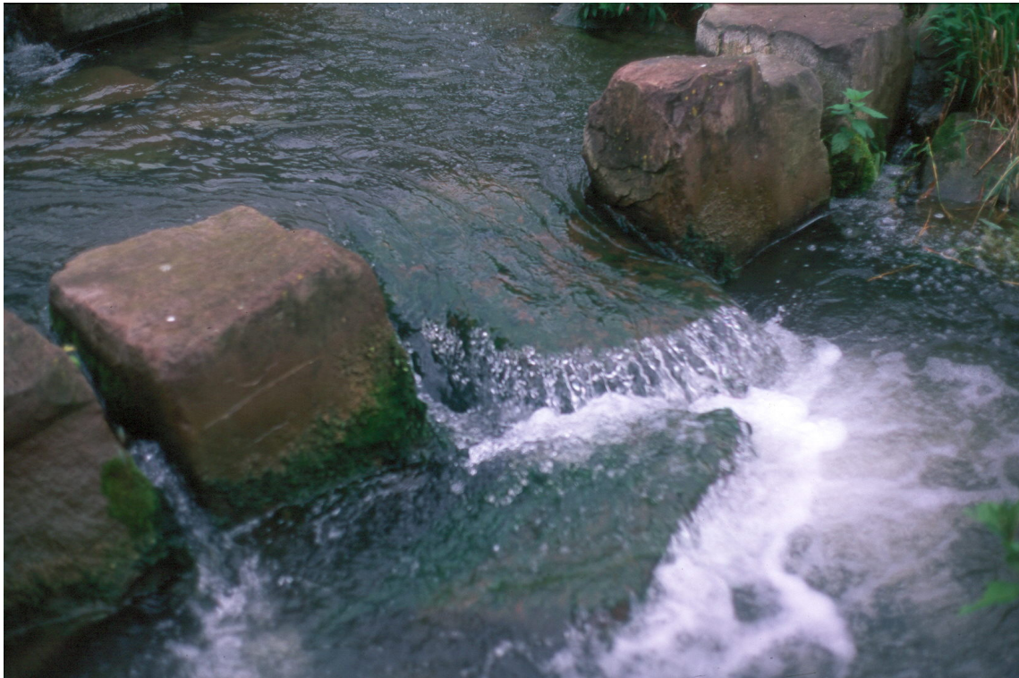
Abb. 6.2: Ein abgelöster Überfallstrahl sowie eine minimale Wassertiefe in den Durchlaßöffnungen schränken die Passierbarkeit der Fischaufstiegsanlage am Ausleitungwehr Trendelburg massiv ein
