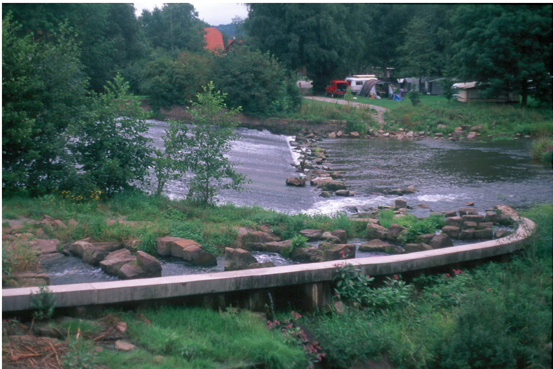
Abb. 6.1: Fischaufstiegsanlage am Ausleitungswehr in Trendelburg
