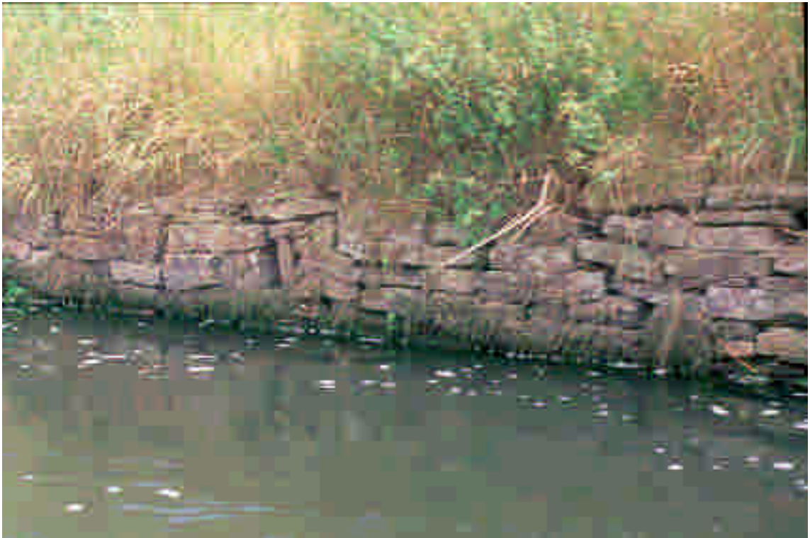
Abb. 4.13: Gabionenartiger Uferverbau unterhalb Trendelburg
