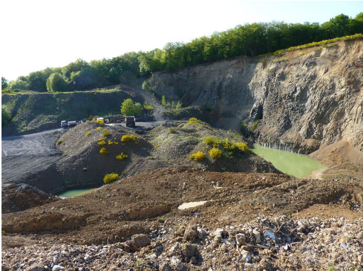
Abb. 37: Basaltsteinbruch am Buschberg bei Elbgrund – eines von lediglich zwei Vorkommen mit einer hervorragenden Gesamtbewertung (LM, Foto: B. Hill).
