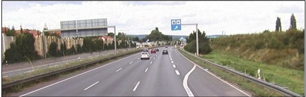
Abbildung 5: Beispiele aufgenommener Schallschutzeinrichtungen Bild oben: Photo aus ZEB-Befahrung mit Lärmschutzwand (im Bild links) und Lärmschutzwall (im Bild rechts) Bild unten: Darstellung der ausgewerteten Lage der Schallschutzeinrichtungen (Schirmkanten gelb) im Orthofoto
