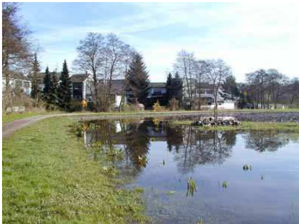
Abb. 24: Vernässungsschäden an Gebäuden (Nauheim)
