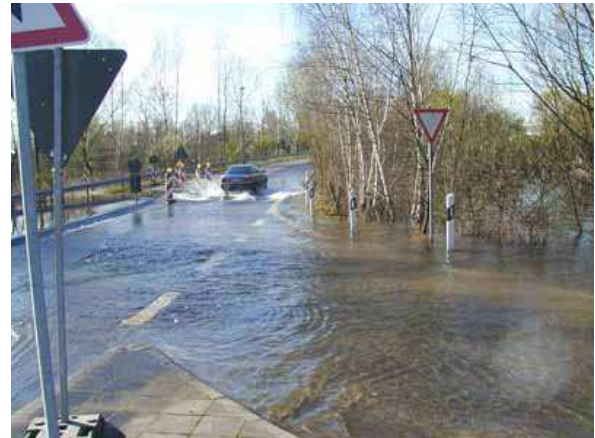
Abb. 25: Überflutete Straßen (Bauschheim/Rüsselsh.)
