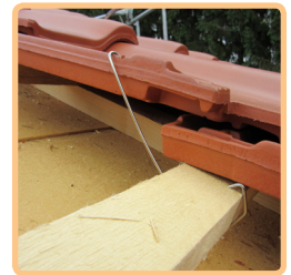
Dachverklammerung. Foto: Handwerkskammer Frankfurt-Rhein-Main, Darmstadt
