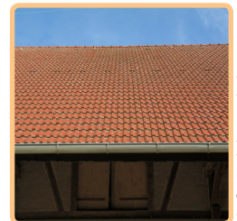
Großer Dachüberstand schützt darunter liegende Gebäudeteile. Foto: Hans Braxmeier, pixabay
