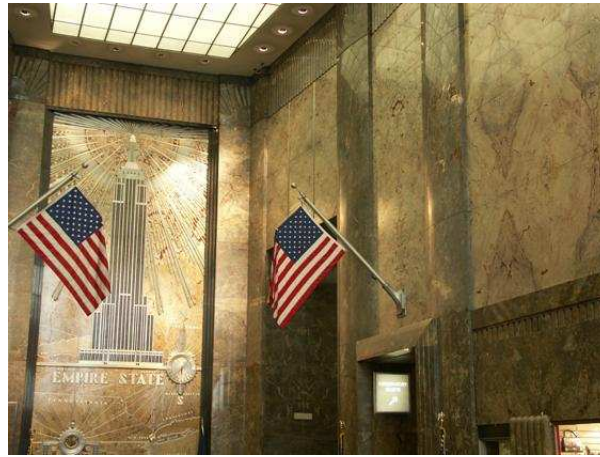
Abb. 2: „Lahnmarmor“ im Empire State Building, New York. Quelle: [2]
