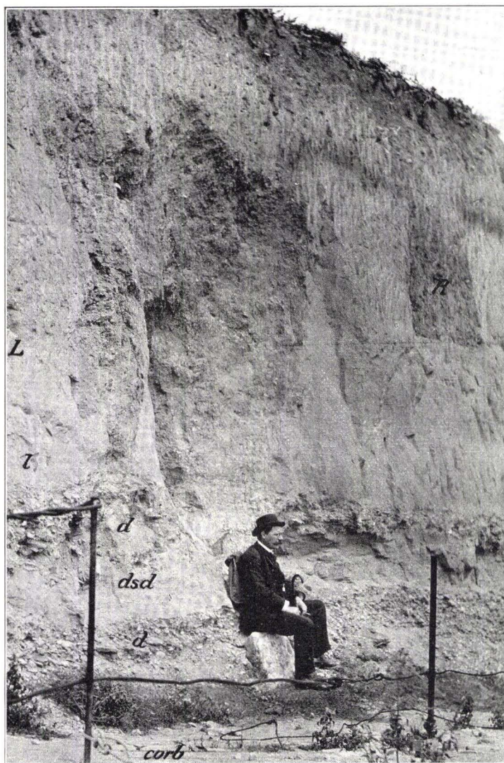
Abraum über der Nordwand des Steinbruches der Weisenauer Zementfabrik. An der Basis Kalk und Mergel mit Hydrobia inflata (corb). Darüber Flußterrasse des Rheins, graue Sande (dsd) und Schotter (d) mit vorwaltenden Geschieben des Mains. Der Beschauer sitzt auf einem Block von Spessartsandstein. Oben Löß (L), in den eine Abfallgrube (R) einer römischen Niederlassung eingesenkt ist. Der Löß ist an der Basis ( \tau ) unrein, das heißt gemischt mit Sand und Kies der Terrasse.
